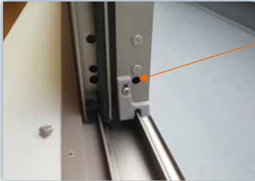
戸車の高さ調整用ネジ
