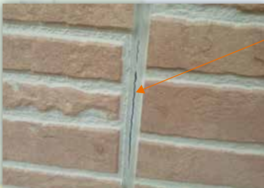
目地シーリング
