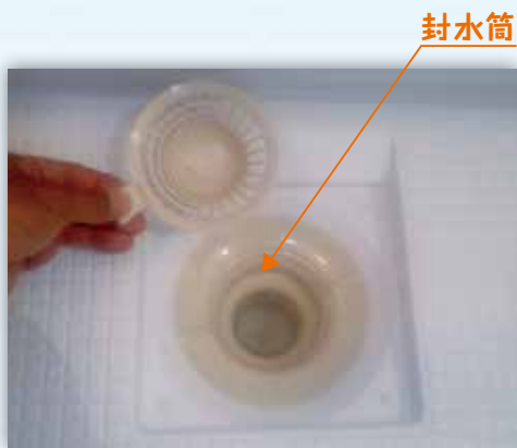
ユニットバス床排水トラップと ヘアキャッチャー
