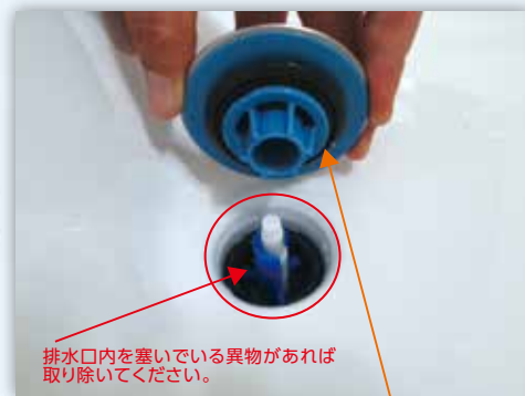
浴槽排水栓 (ポップアップ水栓)
